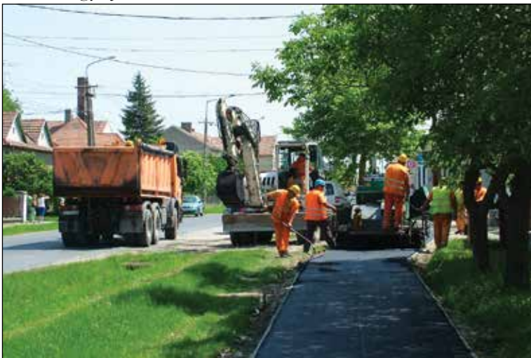
A tíz kilométernyi kerékpárút építése kül- és belterületen párhuzamosan folyt 2013-ban
