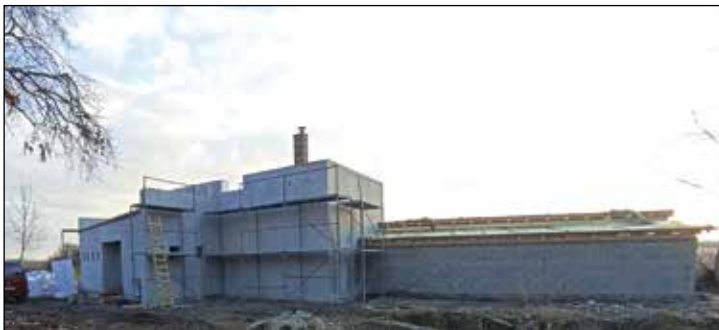
A Kiskunsági Nemzeti Park Igazgatóságának épülő izsáki oktató központja 2022 telén
