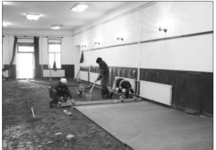
A betonozási munkát az Izsák Kht. dolgozói végezték
